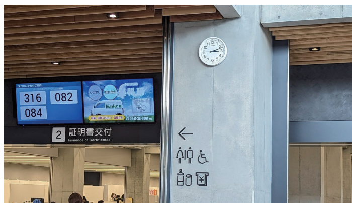
市庁舎窓口に設置されているNTPクロック
